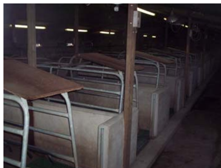
Wyczyszczona chlewnia z usuniętymi deskami
